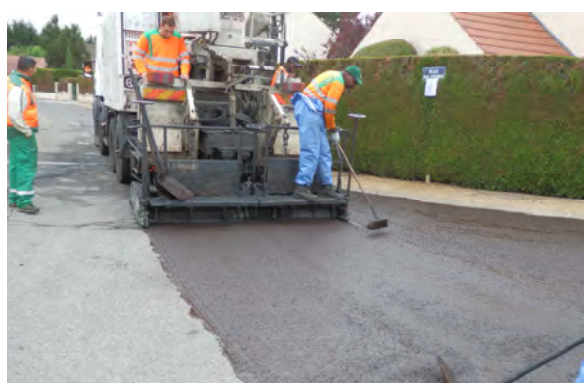
Enrobés coulés à froid route de Rezel
