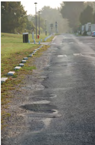
Une chaussée dégradée
