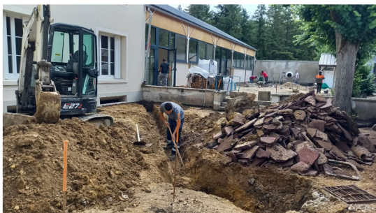
Photos du chantier
