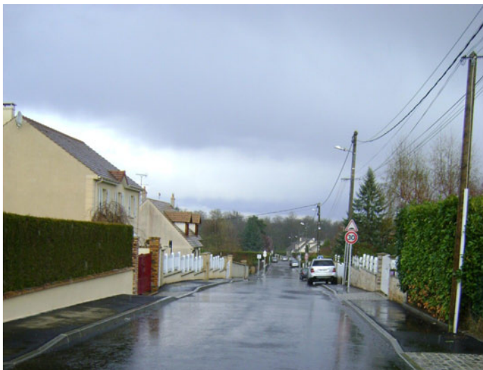
Travaux de voirie achevés Rue des Buttes
