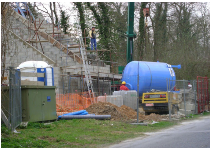
Station de déferrisation de l'eau en construction, route de Rezel : une affaire rondement menée !
