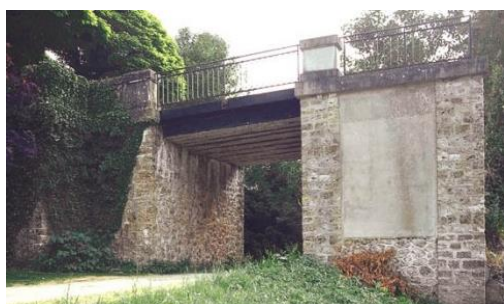
Photo: La tête de pont sur la Marne
