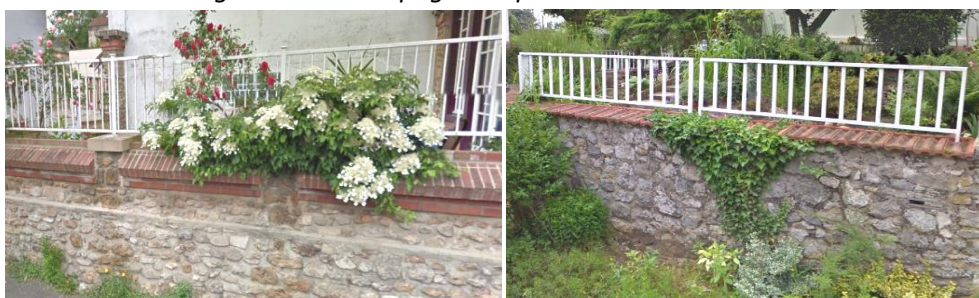
Mur surmonté de grilles et accompagné de plantations
